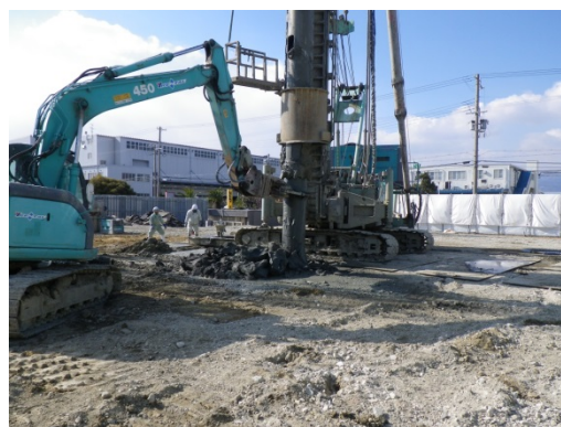
(PG工法によるケーシングからの杭の排出)
