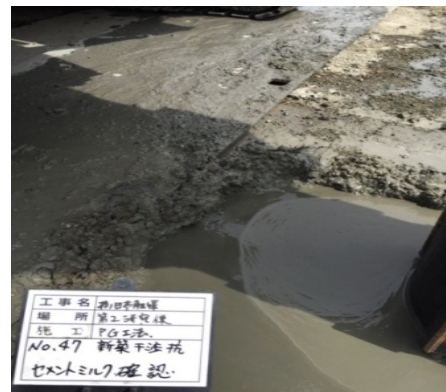
注入状況 オーバーフロー確認
