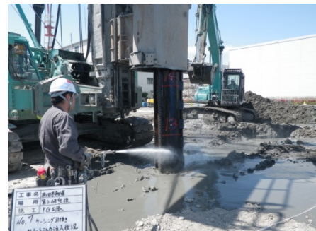
注入継続 液面管理を行いながら引き上げ
