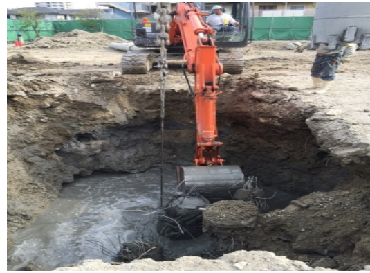
参考資料-4：従来工法の玉掛作業。
